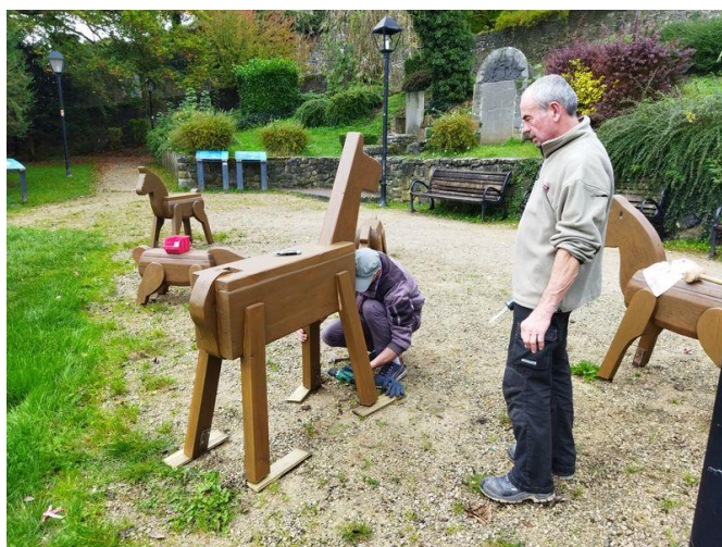
Réparation des jeux en bois dans le parc de VIERVES
