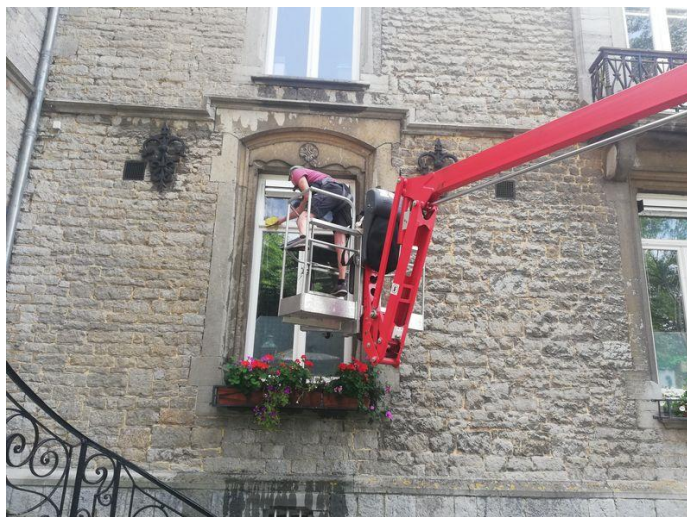
Nettoyage des gouttières et fenêtres du château à NISMES
