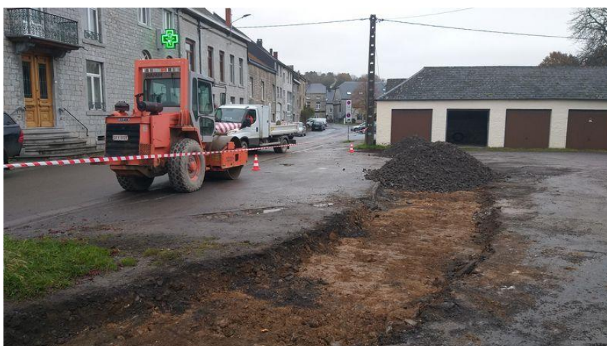
Réparation de parkings rue Longue à NISMES
