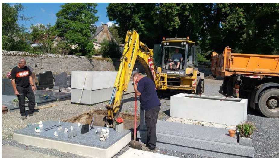
Mise en place de caveaux dans le cimetière rue Ainseveau à NISMES
