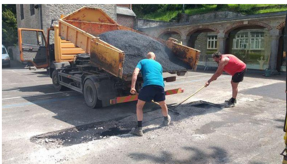
Réparation en asphalte dans la cour de l'école de NISMES
