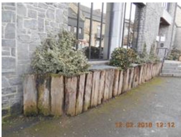
Rénovation de l'entrée du Centre Culturel côté rue Bassidaine à NISMES
