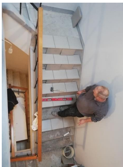
Carrelage des escaliers de service au Centre Administratif de NISMES
