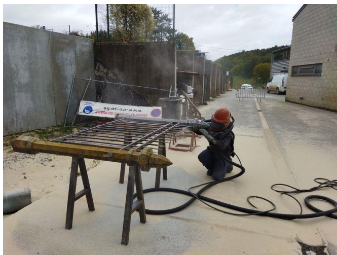
Diverses réparations garage
