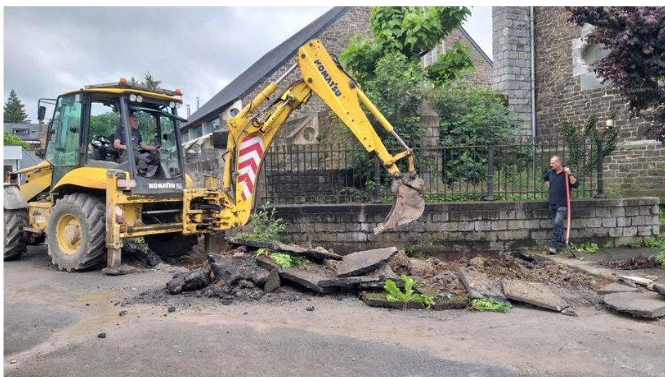
Pose d'un nouvel asphalte dans la cour de l'école communale d'OLLOY
