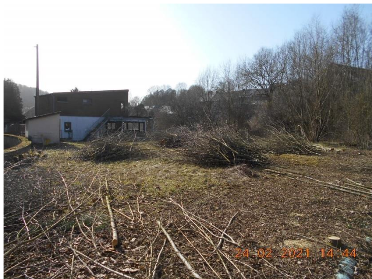
Nettoyage du site de l'ancienne piscine de NISMES
