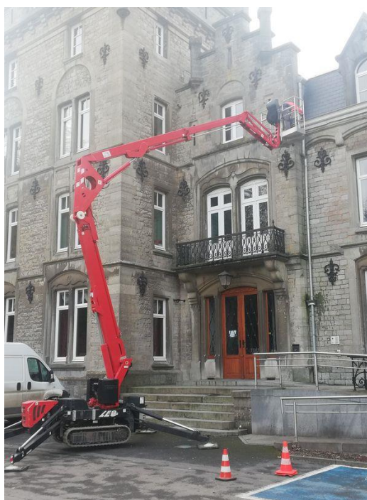
Nettoyage des gouttières et fenêtres du château à NISMES
