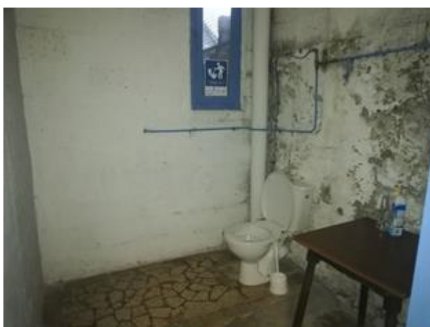
Rénovation des sanitaires de la salle Patria à OLLOY (AVANT)
