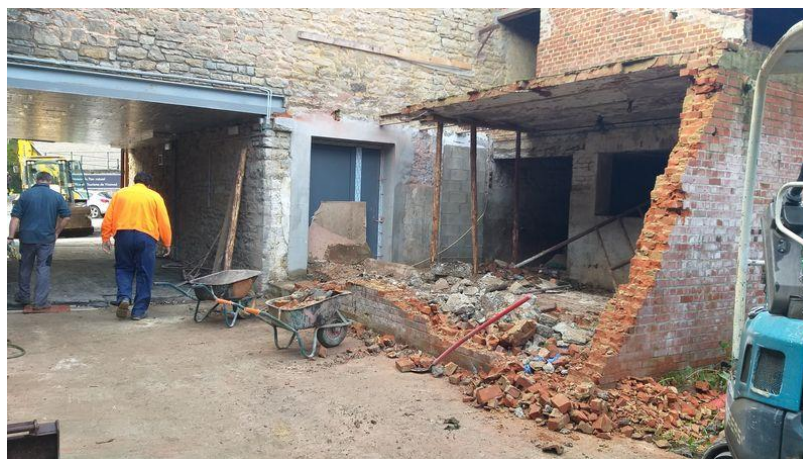
Assainissement des annexes à l'arrière de la « Ferme Jardin » au niveau du Centre Culturel de NISMES
