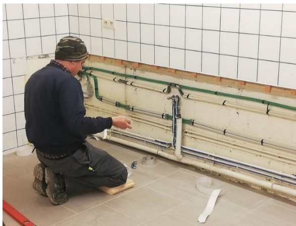
Rénovation de la cuisine de la salle Union Fraternelle de TREIGNES
