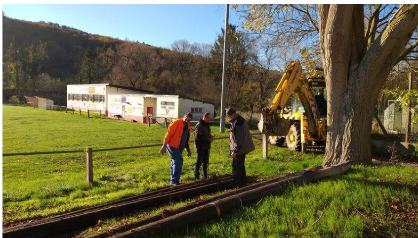
Mise en place de poteaux pour le placement des filets pare-ballon au football de TREIGNES
