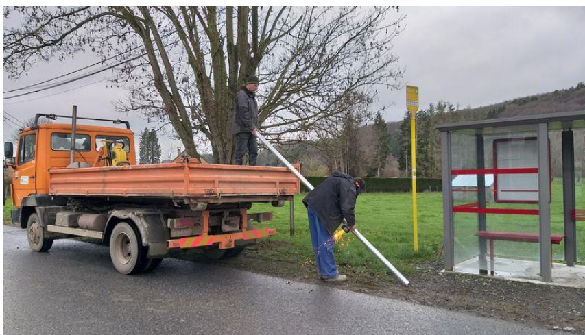
Placement des nouveaux panneaux d'agglomération sur l'entité
