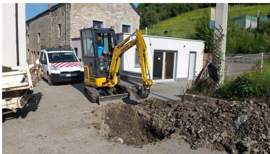
Réparation égouttage rue Fontaine Saint Joseph à VIERVES
