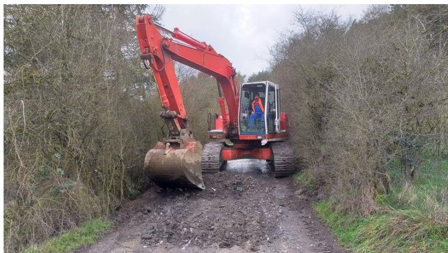
Réparation du chemin vers la carrière Frimoye à OLLOY
