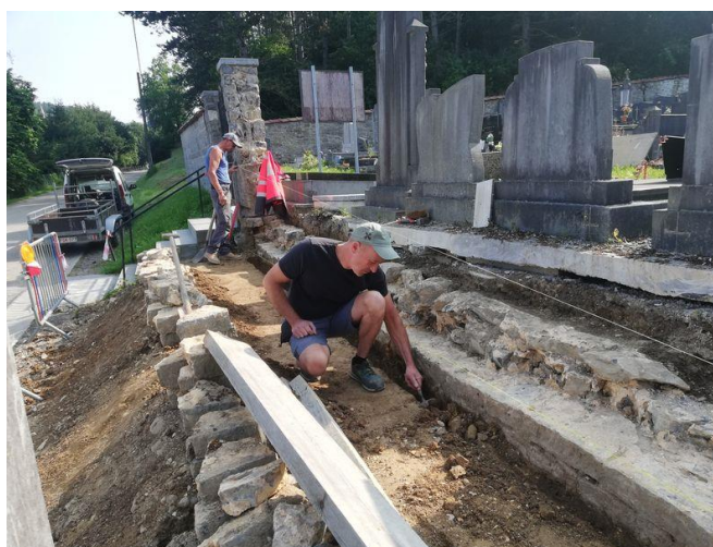
Réparation d'une partie du mur de l'enceinte de l'ancien cimetière de MAZEE
