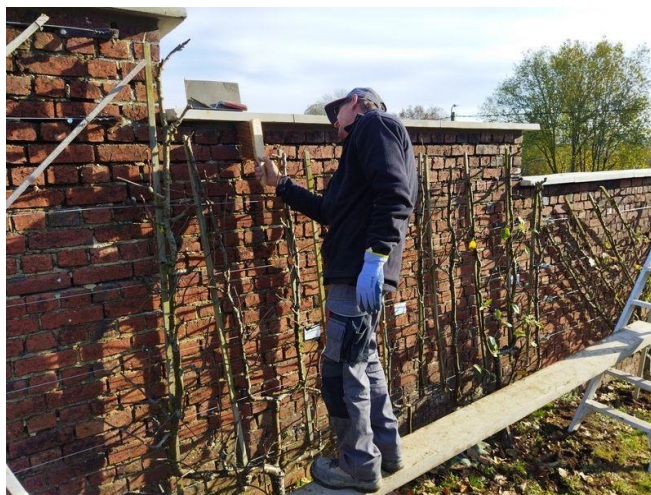
Remplacement des couvre-mur du cimetière de OIGNIES
