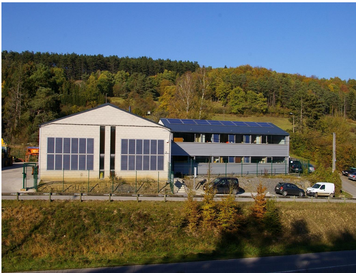
Le Service des Travaux à VIERVES
