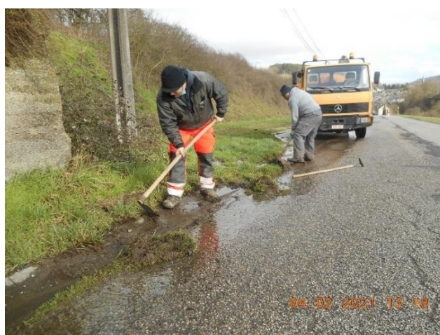
Entretien des filets d'eau rue des Lavandières à VIERVES
