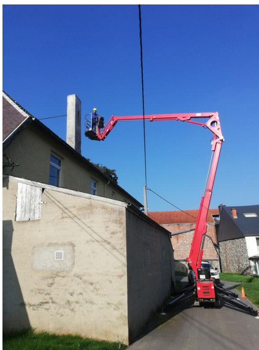
Suppression d'une ancienne cheminée à l'école d'OLLOY
