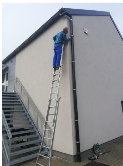
Réparation d'une gouttière au football de NISMES
