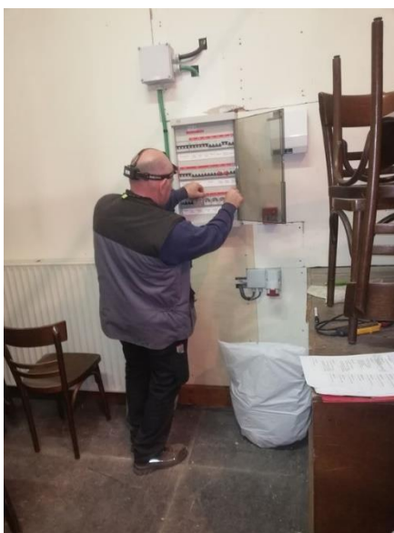
Rénovation de la cuisine de la salle Union Fraternelle de TREIGNES
