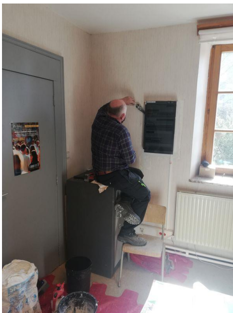
Mise en conformité électrique du château communal à NISMES
