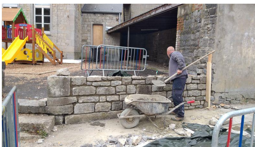
Réparation d'un muret de l'ancienne école de DOURBES
