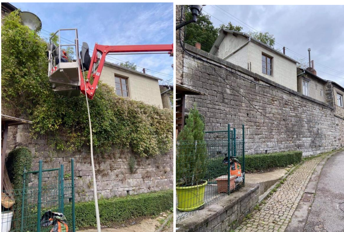
Entretien mur de soutènement rue de Baimont à OLLOY
