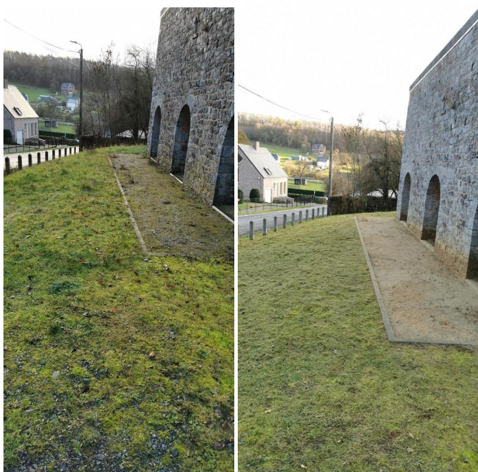
Entretien Four à Chaux à TREIGNES
