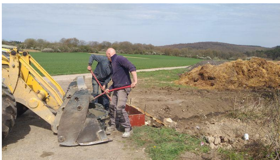
Création d'une tête d'aqueduc rue de Matagne – La - Petite à VIERVES
