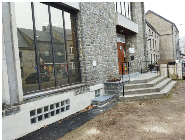
Rénovation de l'entrée du Centre Culturel côté rue Bassidaine à NISMES
