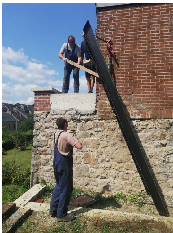
Réparation et aménagement de l'escalier de secours et de la clôture à l'école de OIGNIES
