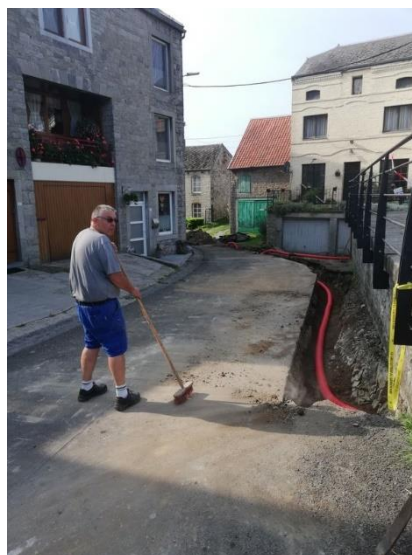
Installation d'un coffret électrique sur la Place de TREIGNES
