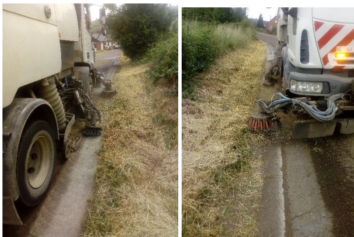
Désherbage filets d'eau avec l'aide de la balayeuse.
