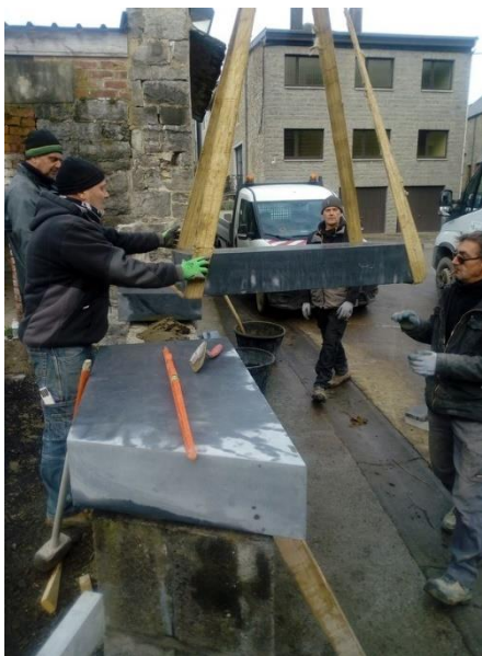
Réparation d'un muret de l'ancienne école de DOUBRES
