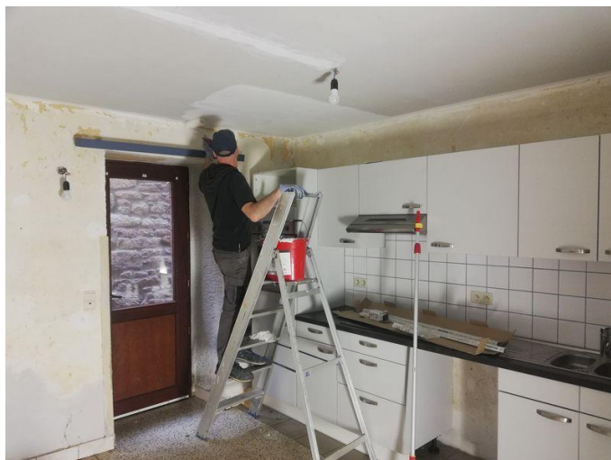
Rafraichissement de la maison rue de Vierves n°6 à OIGNIES suite changement de locataire
