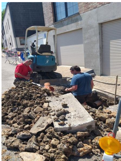
Réparation égouttage rue du Calvaire à NISMES
