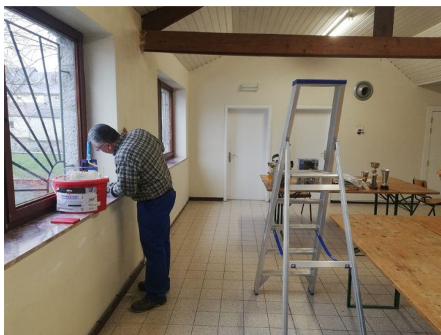
Mise en peinture de la salle Châtillon à NISMES
