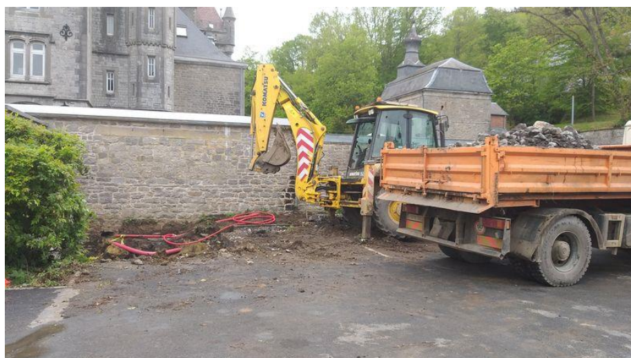
Terrassement et fondation pour accueillir le sanitaire écologique au Parc de NISMES
