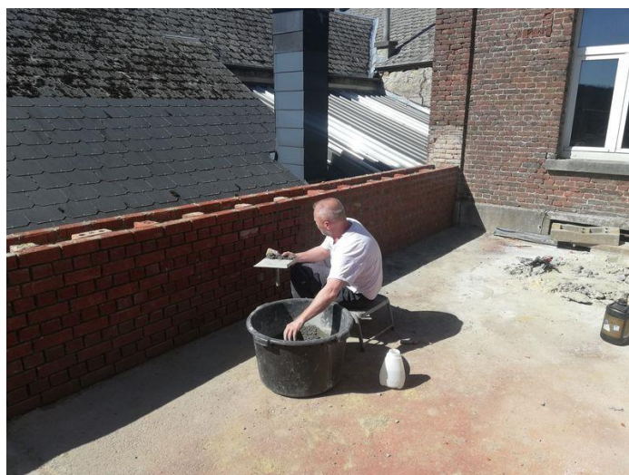
Réparation et aménagement de l'escalier de secours et de la clôture à l'école de OIGNIES
